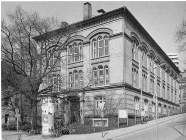
Abbildung 2: Medizinische Abteilung der Universitätsbibliothek Kiel, Südseite und Haupteingang an der Brunswiker Straße (Quelle: Landesamt für Denkmalpflege Schleswig-Holstein)
